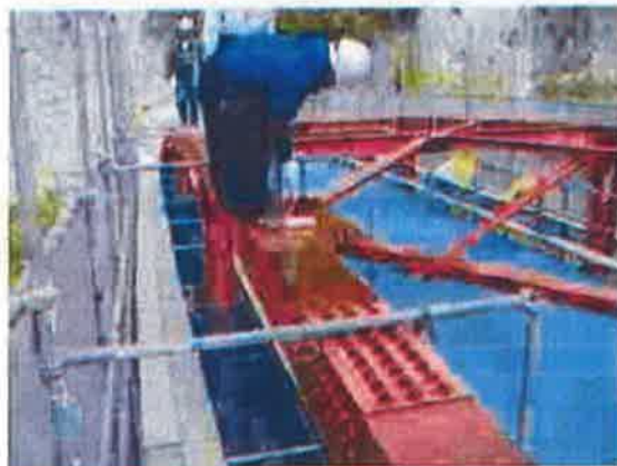
下戸橋補修工事
